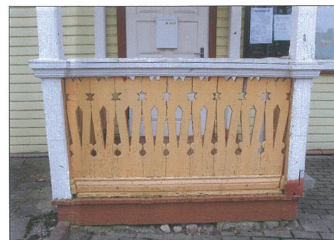
3. Blogos būklės mediniai priebučio turėklai, su pjaustinėtų lentelių piešiniu. Lentų grindys supuvusios.
