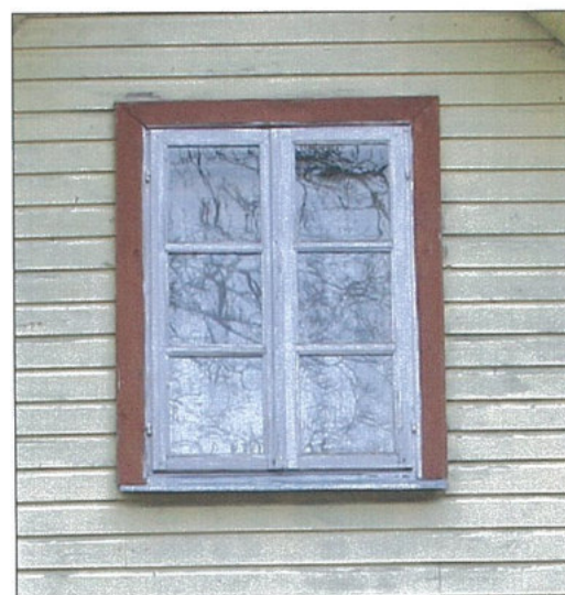
18. P fasade, mansardos langas autentiškas, apvadai pakeisti paprastomis lentomis.
