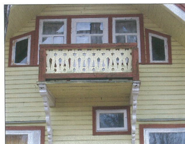
13. Medinės konstrukcijos balkonas, prilaikomas medinių pjaustinėtų gembų, turėklai su pjaustinėtų medinių lentelių piešiniu, balkono konstrukcija su pjaustinėtais sijų ir statramsčių elementais. Būklė patenkinama.
