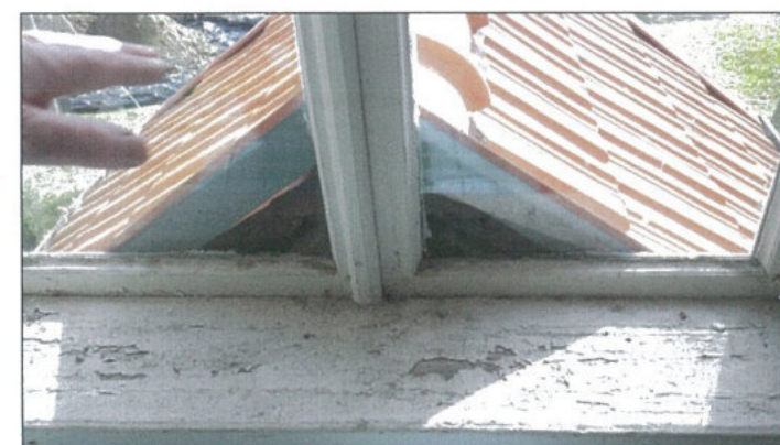
6. Pakeltas priebučio stogas, trukdo atsidaryti mansardos langui. Stogas įrengtas naujai, būklė gera. Palangė supuvusi.
