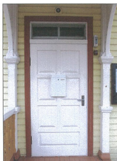
5. Durys naujos, apvadai pakeisti į paprastas lentes, išlikęs autentiškas staktos skersinis elementas.
