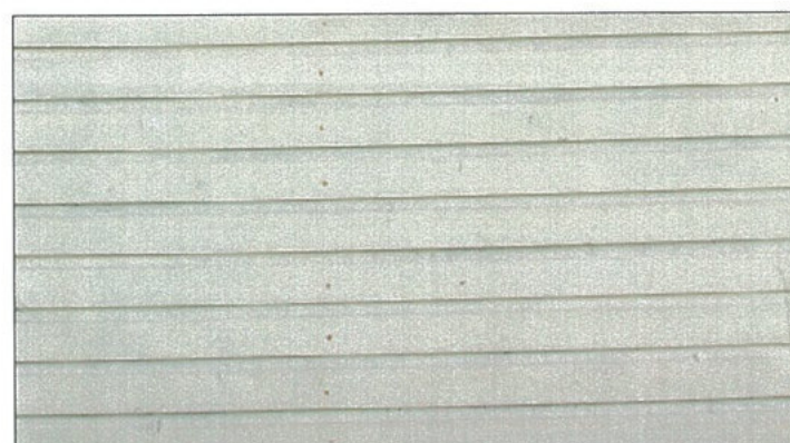
9. Fasado fragmentas. Pakeista fasadų apdaila siauresnėmis medinėmis dailylentėmis.
