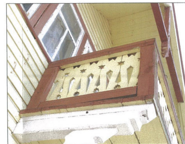
13. Medinės konstrukcijos balkonas, prilaikomas medinių pjaustinėtų gembų, turėklai su pjaustinėtų medinių lentelių piešiniu, balkono konstrukcija su pjaustinėtais sijų ir statramsčių elementais. Būklė patenkinama.
