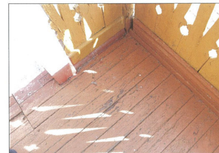
3. Blogos būklės mediniai priebučio turėklai, su pjaustinėtų lentelių piešiniu. Lentų grindys supuvusios.
