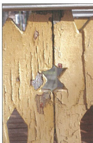
3. Blogos būklės mediniai priebučio turėklai, su pjaustinėtų lentelių piešiniu. Lentų grindys supuvusios.
