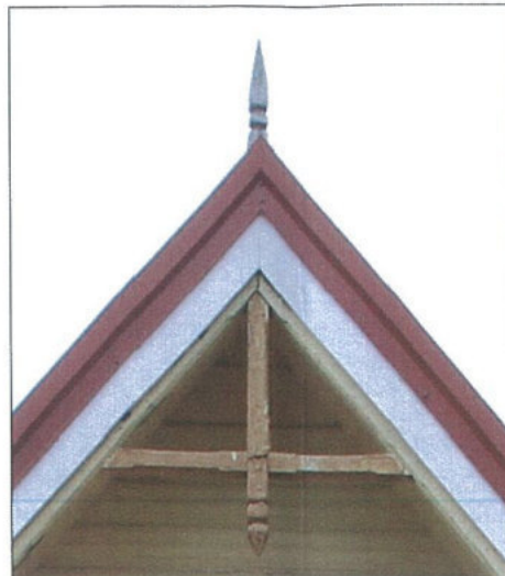
7. Profiliuotos frontono smailės, J. Basanavičiaus g. fasado smailės viršutinė dalis sunykusi.
