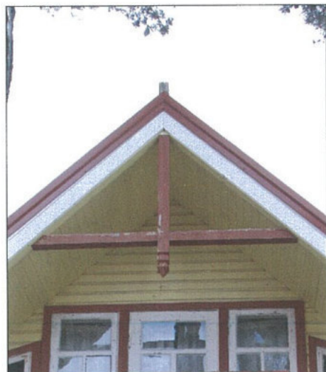
7. Profiliuotos frontono smailės, J. Basanavičiaus g. fasado smailės viršutinė dalis sunykusi.
